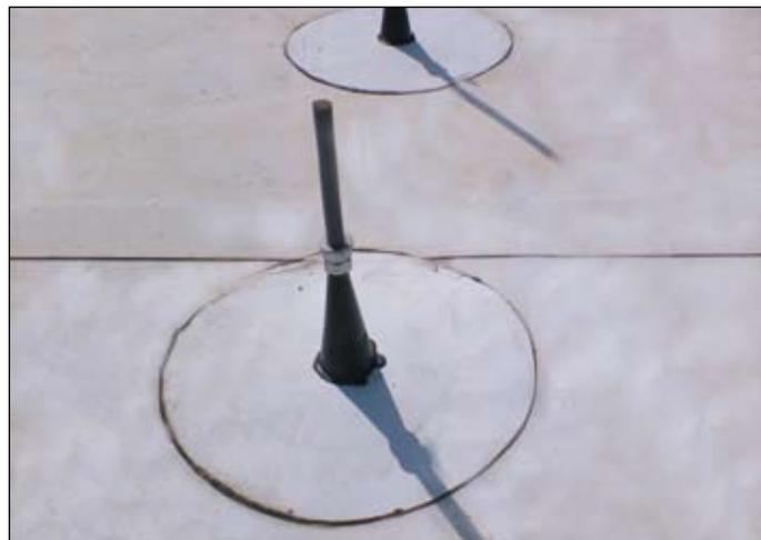
conico di plastica. Il raccordo conico è stato a sua volta sigillato con DERBIMASTIC S.
